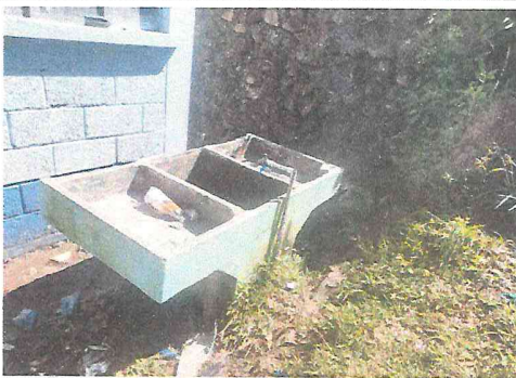
Foto 5: pila de cemento deteriorada.
